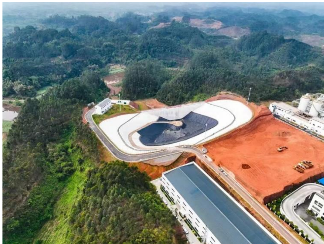
乐山市生活垃圾应急填埋场项目实景图
