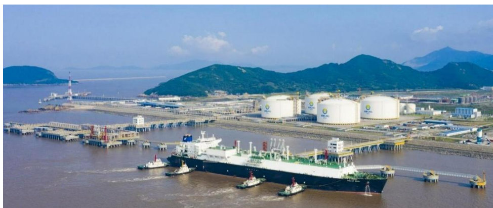
舟山 LNG 接收站
