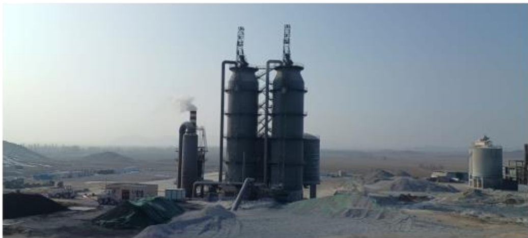
聚鑫钙业 氧化钙（环保竖窑）生产线
