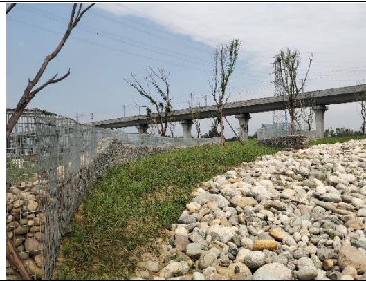
桥梁径流收集工程
