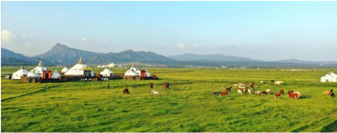
敕勒川生态谷项目实景照片
