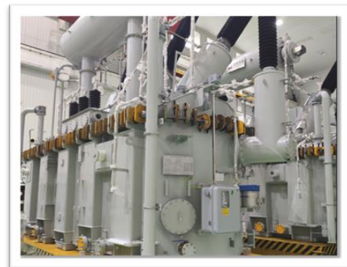
项目名称：马来西亚某数据中心
