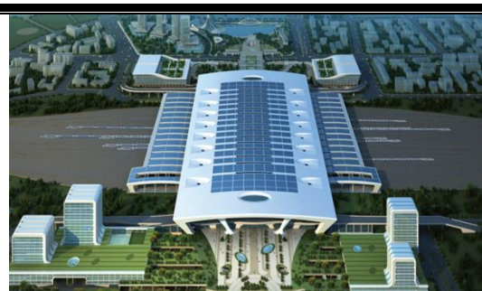
杭州东站 10MW 光伏电站
